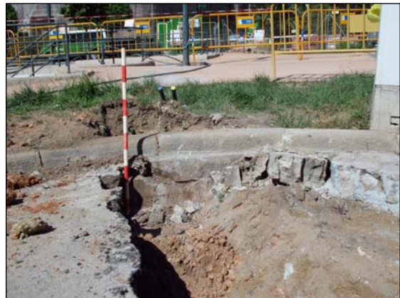
Vista de la rasa 600A amb la vorera u.e. 612 i el cable elèctric u.e. 614 i de la rasa 600E amb vorera u.e. 615.
