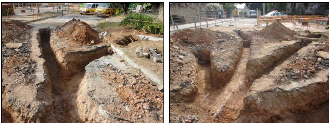
Vistes generals de diversos trams de la rasa 400, de esquerra a dreta: A, B, C, D, E i F.
