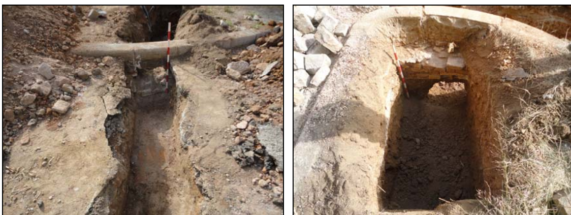
Vistes de les voreres u.e. 409 i 410 amb les seves fonamentacions u.e. 411 i 412.
