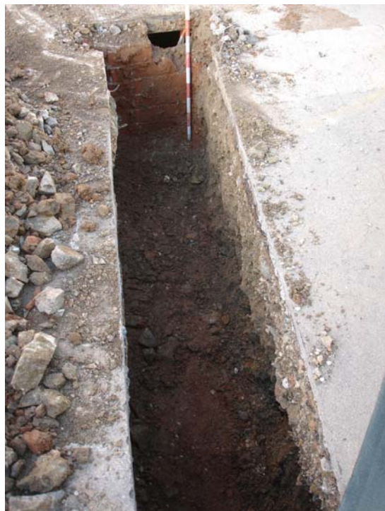
Vista des del sud-oest del tram 900C amb l'arqueta u.e. 938 al fons.
