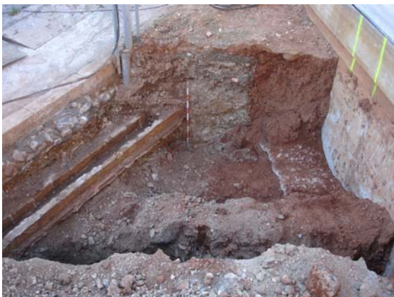
Vista des de l'est de l'extrem nord de la rasa 900, amb la sala de calderes u.e. 907 a la dreta i la claveguera u.e. 914 i la vorera u.e. 911 a l'esquerra
