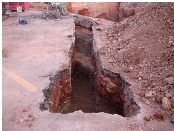
Vista des del sud del tram 900A, travessat pels cables elèctrics u.e. 919 i 922-923 i la vorera u.e. 911 al fons
