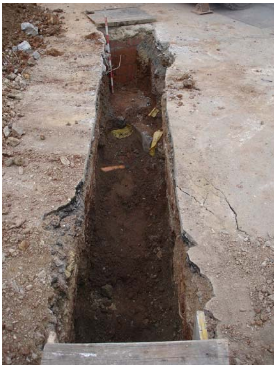
Vista des de l'oest del tram 900B amb l'arqueta u.e. 938 al fons i els serveis elèctrics i de gas u.e. 935 i 932 davant.
