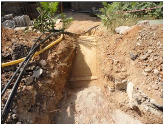
Vista des del nord de la galeria subterrània u.e. 304.
