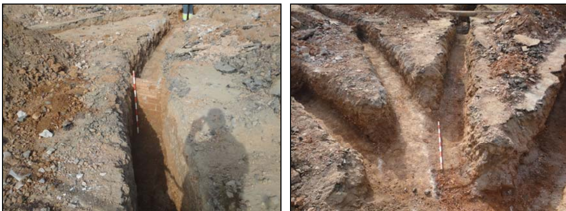
Vista de l'envà de maons u.e. 406 i del prisma de formigó u.e. 407.
