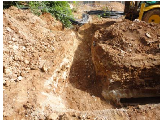
Vista des del sud de l'extrem sud de la rasa 300, amb la sala de màquines u.e. 312 a la dreta
