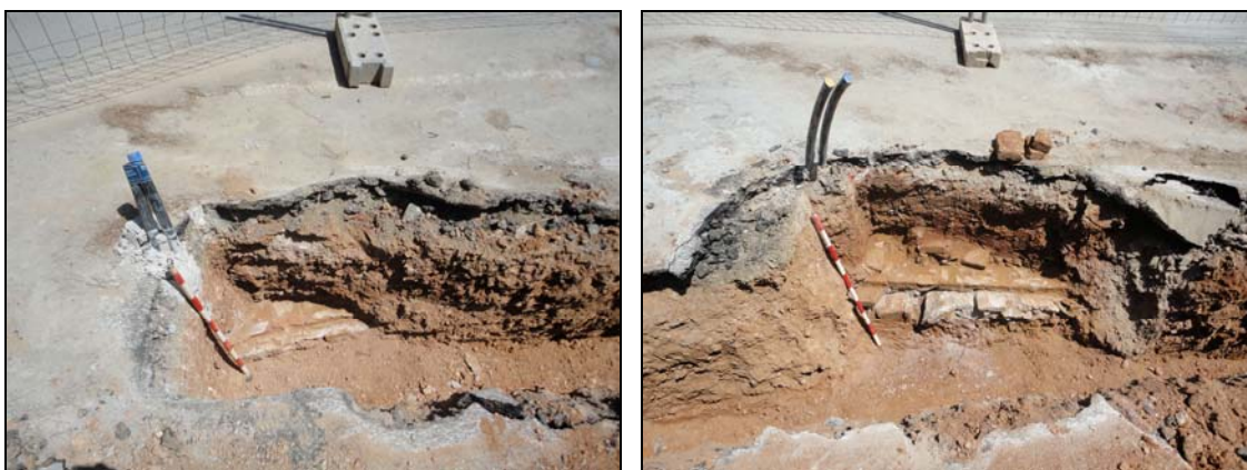
Vista des del sud de diversos trams descoberts de la caixa de cable elèctric u.e. 203.
