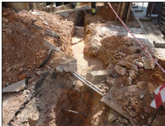
Vista des de l'oest de la galeria subterrània u.e. 102 a l'extrem oest de la rasa 100 B.
