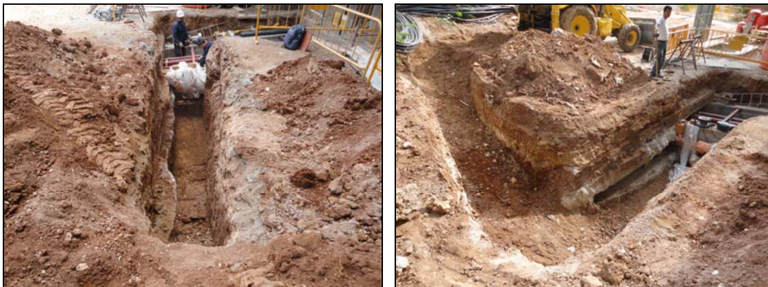
Vista des de l'oest i des del sud-oest de la rasa 500, amb la sala de màquines u.e. 503.
