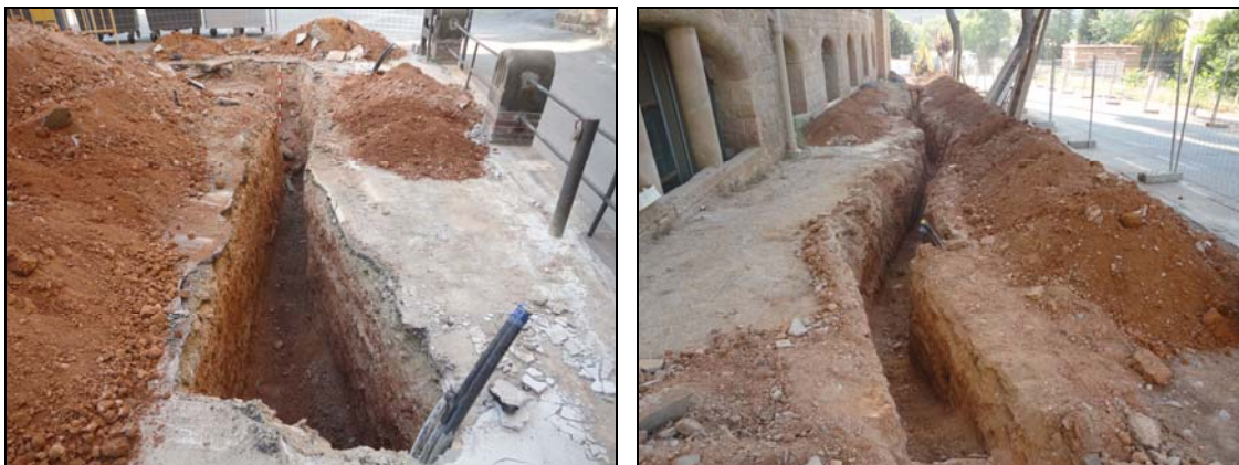
Vista dels trams A i B de la rasa 100.
