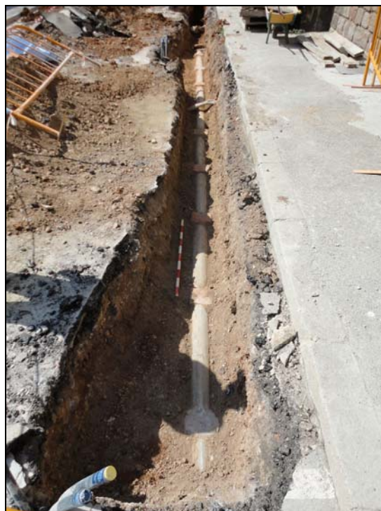
Vista des del sud i des del nord de la rasa 100C, amb la canonada de fibrociment u.e. 113 a la dreta.
